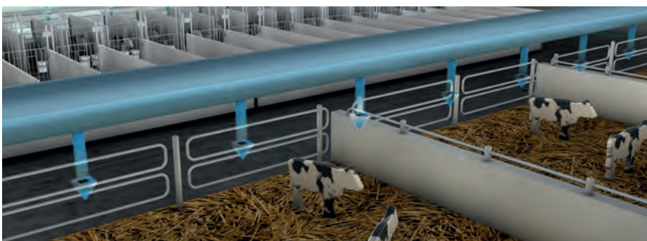
Schlauchüberdrückbelüftung als konstante Frischluftversorgung in Gruppen- und Einzelboxen.
